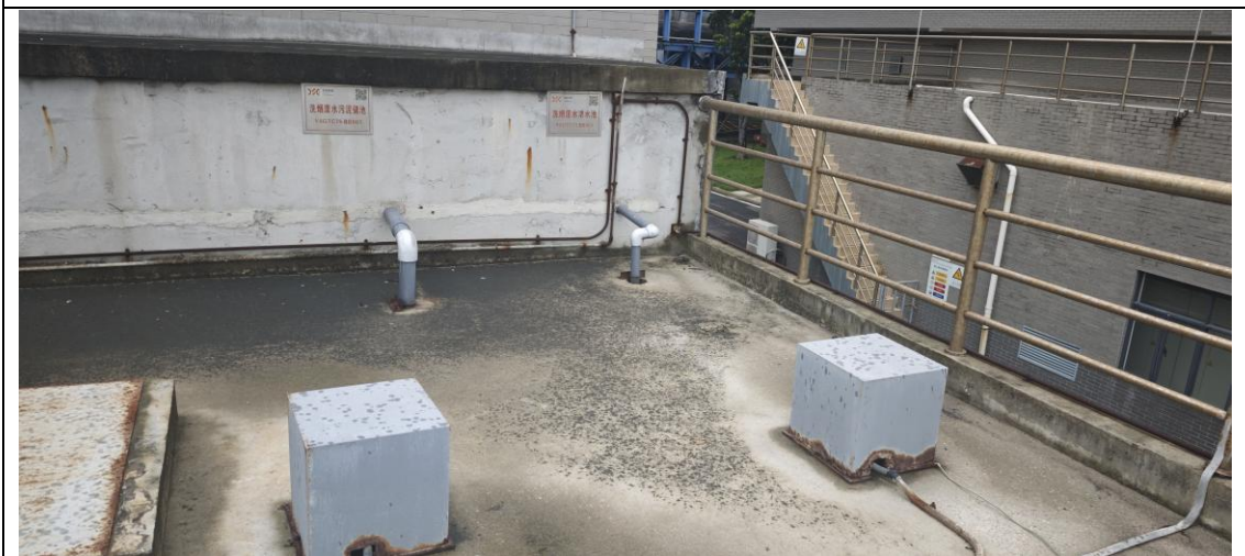
循环水排污水膜设备系统一级 RO 膜产水接入口，位于生产消防水池池顶，池顶高度 7 米
