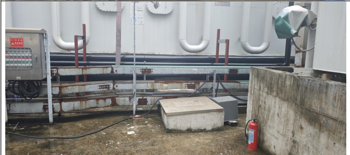
循环水排污水膜设备系统一级 RO 膜产水接入口，位于生产消防水池池顶，池顶高度 7 米
