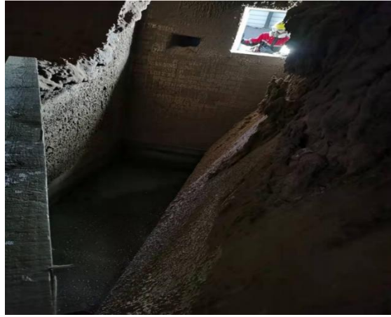
图 1 二燃室底部（内部中空）
